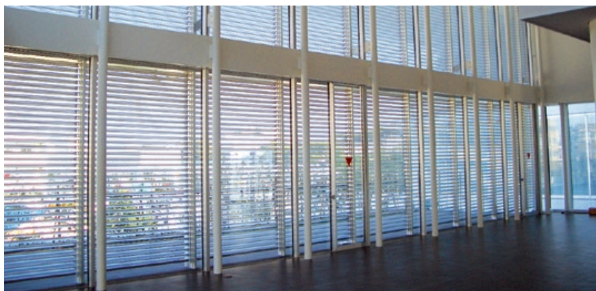
施工物件：日東工器(株)様本社ビル（東京都大田区）
