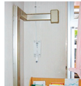
■ オペレーターボックス改修箇所
