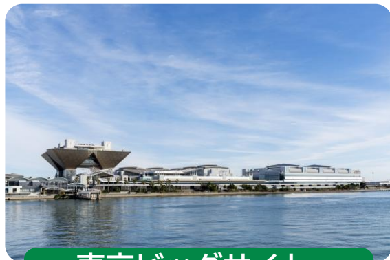
東京ビッグサイト (会議棟・西展示棟・南展示棟)
