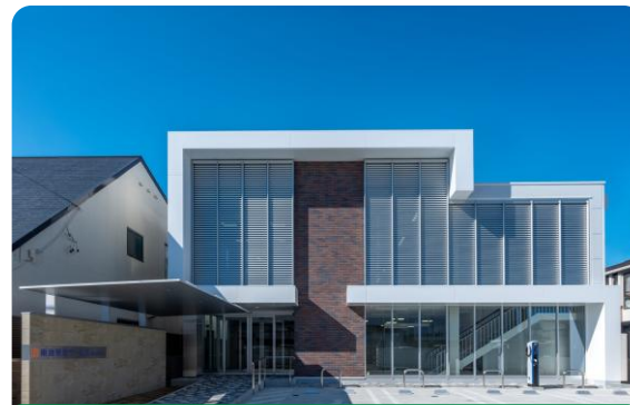
東海理化サービス 本社ビル
