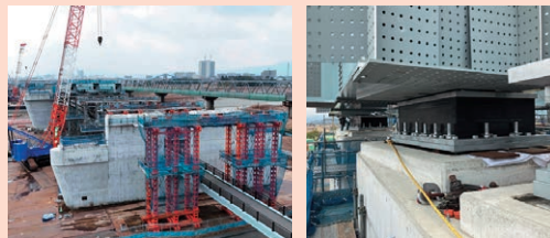
工事の様子。バイパスの下に歩道橋が通っている国内屈指の特殊な形状。
