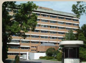
『山梨県庁舎』▶ 鉄筋コンクリート造
