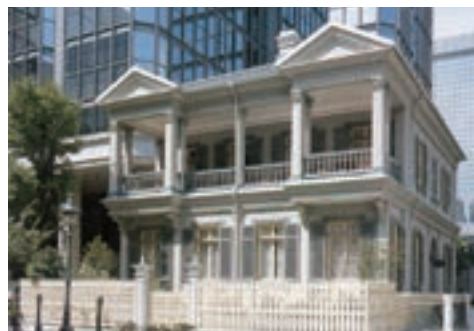
旧神戸居留地十五番館:免震装置 LRB(レトロフィット)
