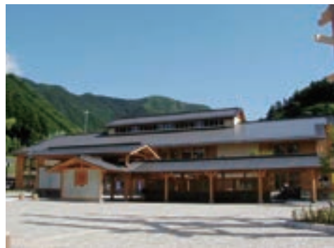
波賀町庁舎:免震装置 FPS
